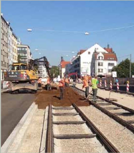
Substrateinbau an der Tramlinie 19 in München mit dem Volvo EW160 und unserem Team
