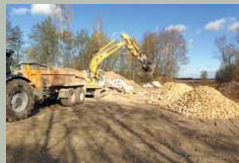
Auf den kommunalen Baustellen versuchen wir vor dem Winter fertig zu werden.
