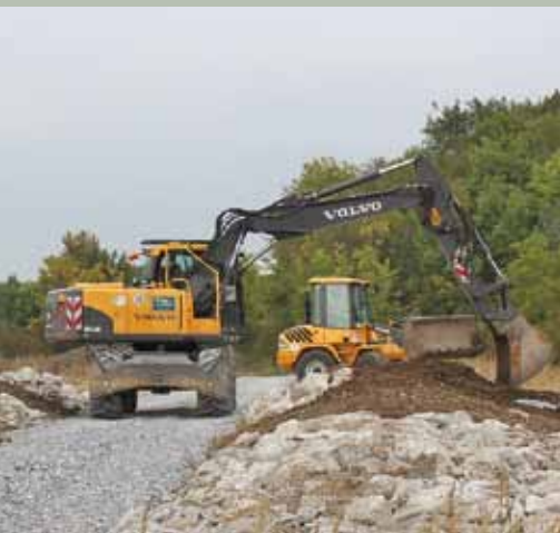
Mobilbagger und Radlader errichten Eidechsenhabitats auf einer Ausgleichsfläche in München.
