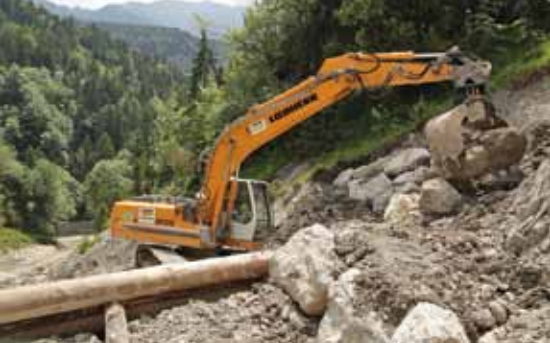
Für eine Talsperre an der Flussmeisterstelle in Benediktbeuren bewegt der Liebherr 906R große Steine.
