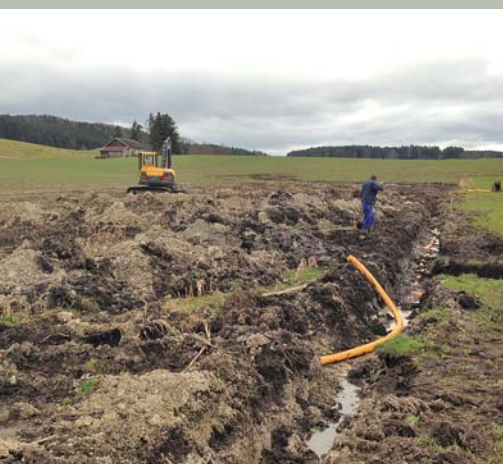
Drainageinstandsetzungsarbeiten auf dem Weizenacker eines Kunden
